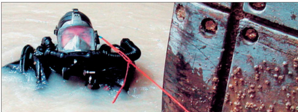
В мутных водах в порту Умм-Каср (Ирак) обследование причальных сооружений проводилось водолазами вручную
