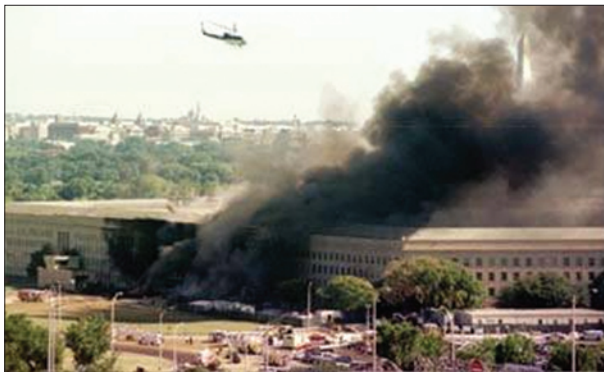
США. 11 сентября 2001 года. В результате действий террористов разрушен Всемирный торговый центр в г. Нью-Йорк (рис. сверху) и повреждено здание Пентагона в г. Вашингтон (внизу)
